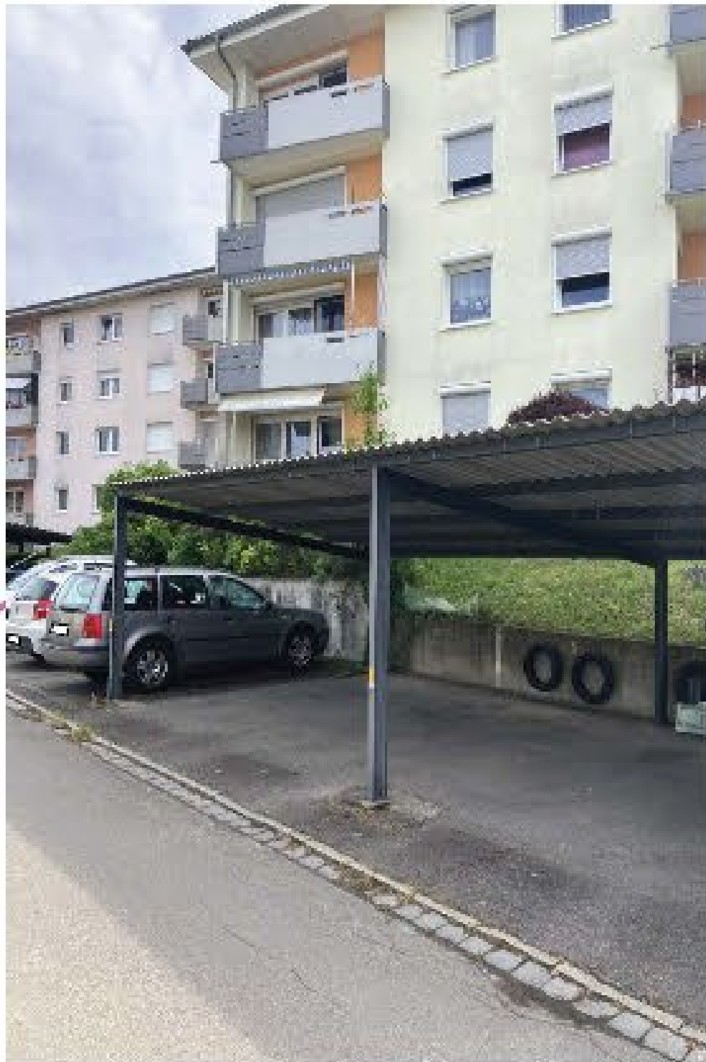
Entwässerung auf Straße (Barbelgänge)
