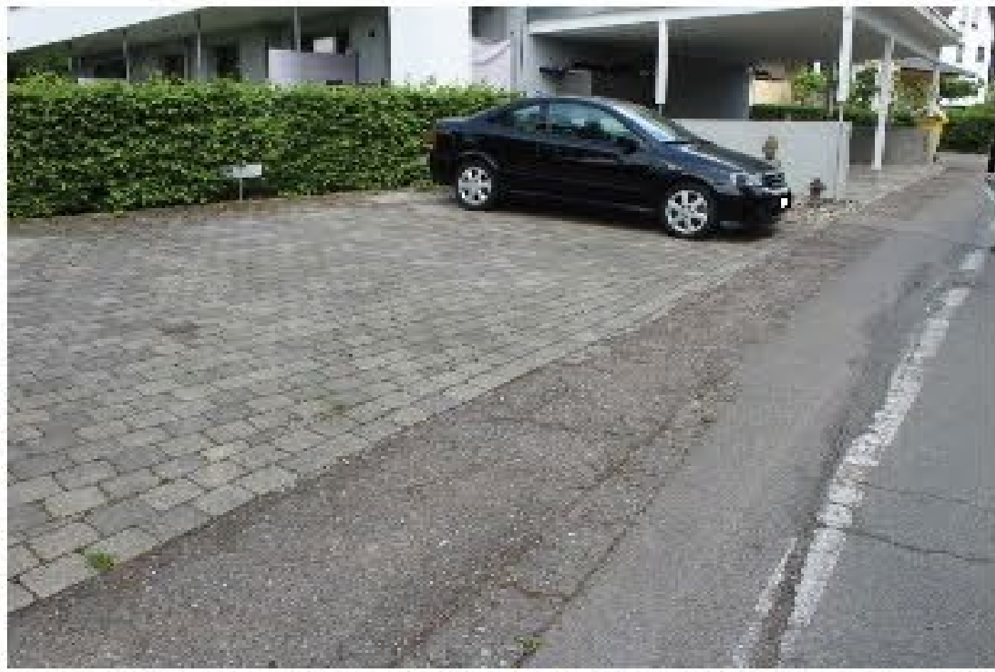
Entwässerung auf die Straße (Alte Owinger Str.)
