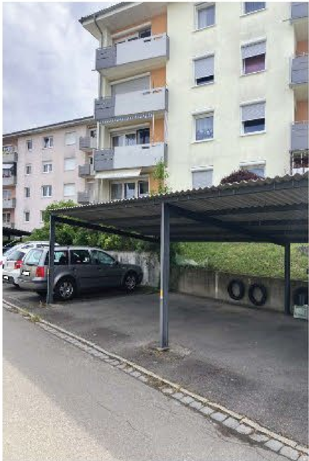
Entwässerung auf Straße (Barbelgänge)
