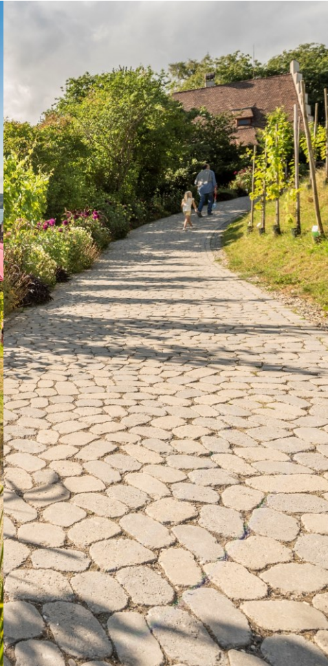
Versickerung über Splittfuge
