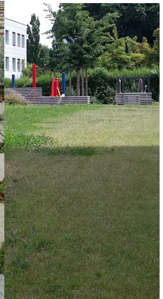
Schotterrassen in Feuerwehruzufahrt
